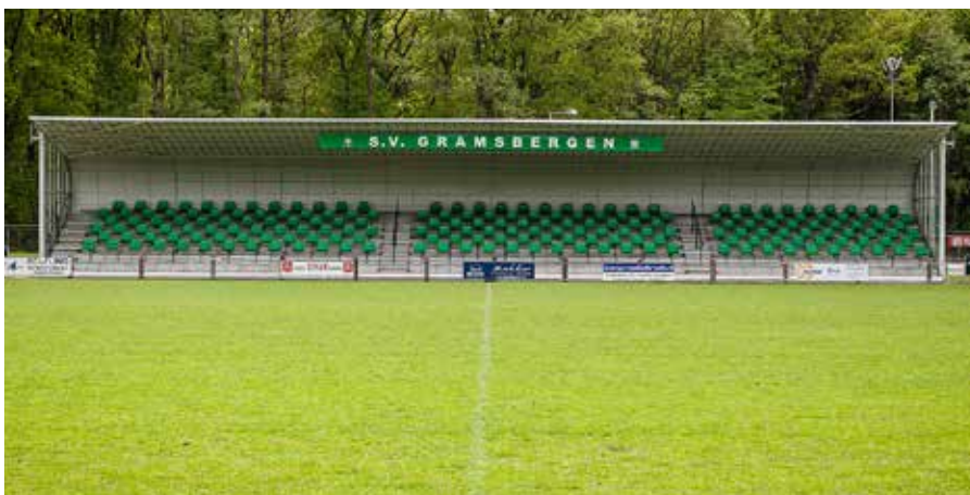
Vasemmalla SV Gramsbergenin uudelleenrakennettu katsomo on valmis uuteen kuumasinkityn teräksen käyttökertaan. Rakenteen kokonaiselinajaksi voi tulla yhteensä 100 vuotta
