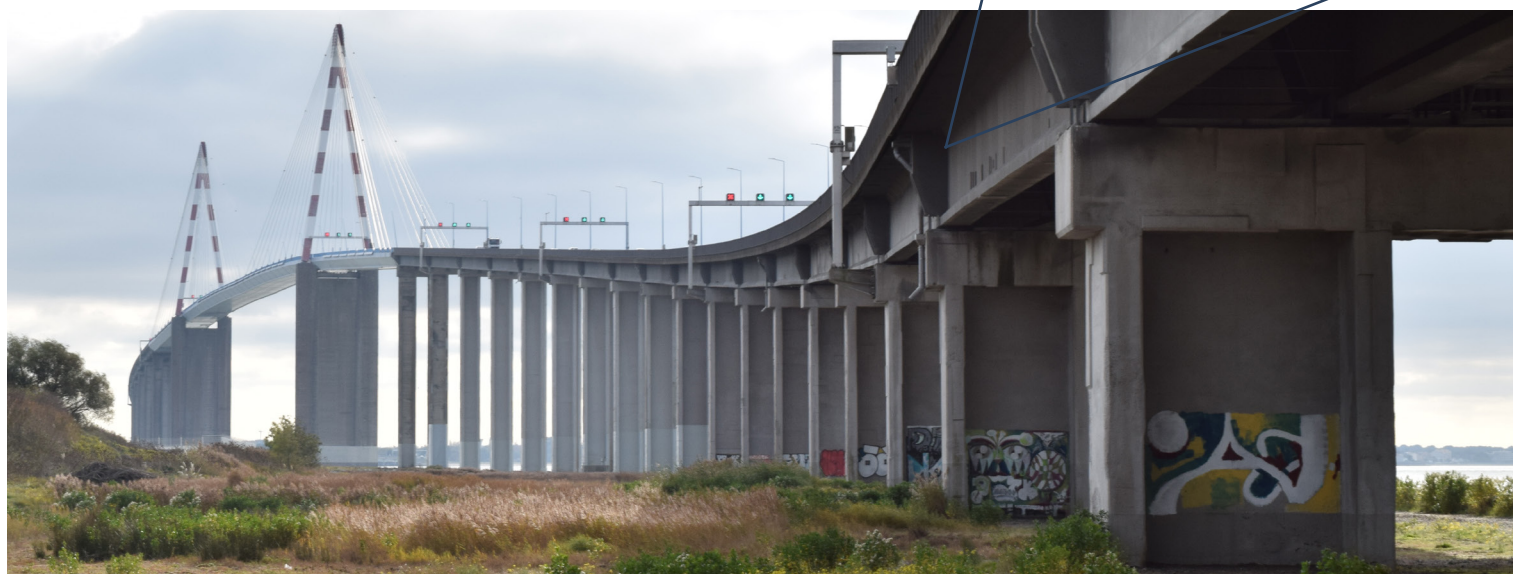
Podul Saint-Nazaire a fost construit în anii 1970 și este încă și astăzi cel mai lung pod din Franța. Cea mai mare parte a armăturii din beton nu a fost protejată împotriva coroziunii. Este unul dintre factorii care au condus la un program extins de întreținere și reparații. Aproximativ 63 de tone de armătură din oțel zincat au fost utilizate în locații foarte specifice - flanșele capetelor grinzilor în T și plăcile de conectare turnate la fața locului la înălțimea flanșelor (în imaginea de mai sus). Nu au fost necesare reparații în locațiile specifice unde a fost utilizată armătura zincată termic.
