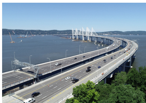
Podul Mario M. Cuomo este un pod hobanat cu două deschideri, cu 8 benzi, lung de 5 km, proiectat pentru o durată de viață minimă de 100 de ani, folosind armătură zincată termic.
