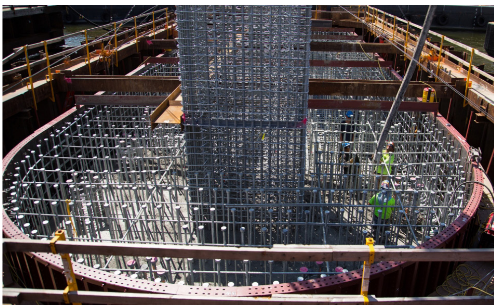
Cele 43 de perechi de piloni de beton ai podului Mario M. Cuomo sunt armate cu colivii din oțel zincat termic.
