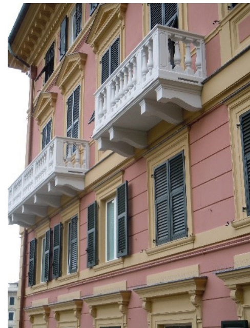
Grinzi de susținere din beton armat cu oțel zincat termic pentru balcoanele unui apartament elegant din Genova. Armătura din oțel zincat termic a fost aleasă pentru a conserva cât mai bine grinziile de susținere ale balcoanelor în timp, în special pentru a le proteja de smog, ploaie, îngheț și umiditate. (Imagini oferite de Prefabbricati Torti di Pietro e Lino Torti snc)
