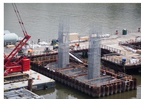
Peste 27.000 de tone de armătură din oțel zincate termic asigură durabilitatea pe termen lung a turnurilor principale, a piloților de acces, a culeelor și a panourilor tablărilor rutier al podului Mario M. Cuomo.
