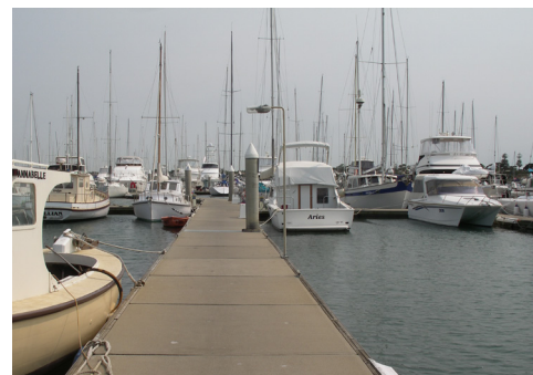
Pontoanele plutitoare de la marina din Sandringham, Victoria (Australia) au folosit armătură zincată termic.
