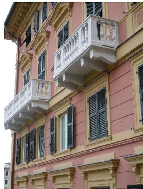
*Mensole in cemento armato realizzate con acciaio zincato a caldo per i balconi di un elegante appartamento a Genova. L'armatura in acciaio zincato è stata scelta per preservare al meglio le mensole nel tempo, in particolare per proteggerle da smog, piogge, gelo e umidità. (Immagini gentilmente concesse dall'azienda Prefabbricati Torti di Pietro e Lino Torti snc)*
