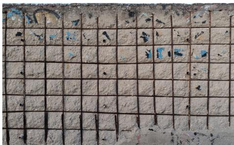
**B. La fase di propagazione** - la distruzione dello strato di passivazione sulle armature si è verificata e l'acciaio si sta corrodendo. Alla fine di questa fase si verificano la delaminazione o la rottura del calcestruzzo.
