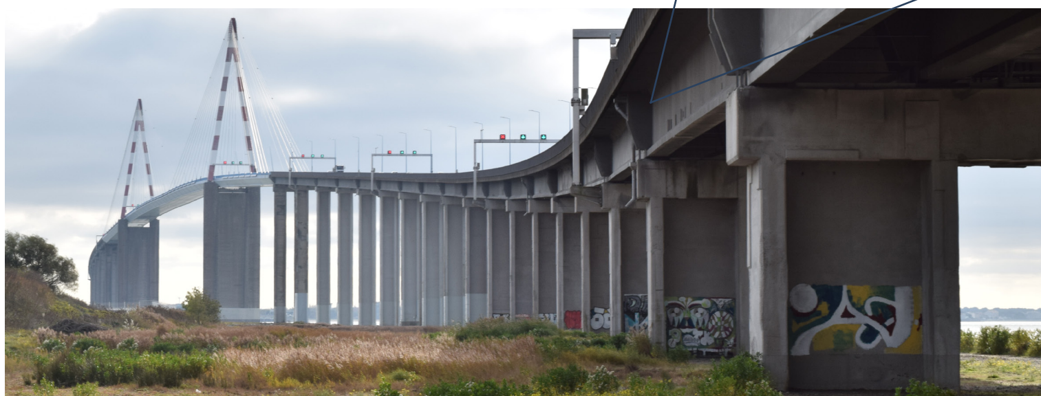
De Saint-Nazaire brug werd gebouwd in de jaren 1970 en is nog steeds de langste brug in Frankrijk. Het grootste deel van de betonwapening was niet beschermd tegen corrosie en dit heeft geleid tot een uitgebreid programma van onderhoud en reparaties. Ongeveer 63 ton verzinkte stalen wapening werd gebruikt op zeer specifieke locaties - de flenzen van de T-balkuiteinden en de ter plaatse gegoten verbindingssplaten ter hoogte van de flenzen (zie foto hierboven). Reparaties waren niet nodig op die specifieke locaties waar de thermisch verzinkte wapening werd gebruikt.
