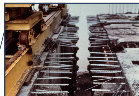
Het brugdek van de Mario M. Cuomobrug bestaat uit bijna 6000 prefab panelen, elk 3,66 m lang en 6,7-13,7 m breed, voor de toegangsoverspanningen en 963 dekpanelen voor de hoofdo overspanning. De panelen worden samengevoegd door beton rond de uitstekende thermisch verzinkte stalen wapening te gieten. (Afbeelding met dank aan de New York State Thruway Authority)
