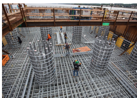
Voorafgaand aan de keuze voor verzinkt betonstaal voor de Mario M. Cuomobrug ontwikkelde de New York Thruway Authority een corrosiebeschermingsplan om de blootstelling, degradatiemechanismen, ontwerp- en constructiedetails en levenscycluskosten vast te stellen.
