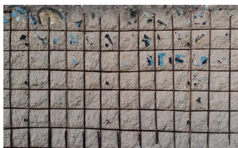
Agrietamiento y desmenuamiento del hormigón debido a la corrosión de la armadura
