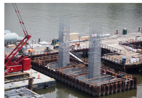
Plus de 27 000 tonnes d'armatures en acier galvanisé assurent la durabilité à long terme des tours de la travée principale, des piles des travées d'approche, des culées et des panneaux du tablier routier du pont Mario M. Cuomo.
