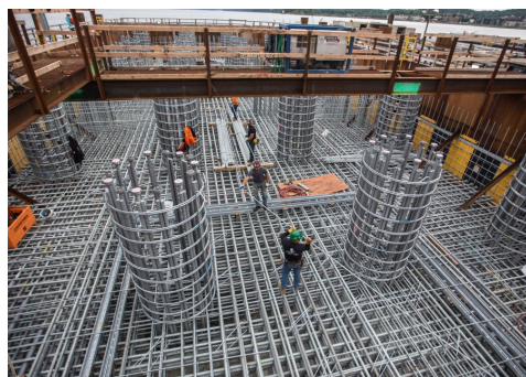
Avant de choisir les armatures galvanisées pour le pont Mario M. Cuomo, la New York Thruway Authority a élaboré un plan de protection contre la corrosion afin d'identifier l'exposition, les mécanismes de dégradation, les stratégies de conception et de construction, ainsi que les coûts du cycle de vie.
