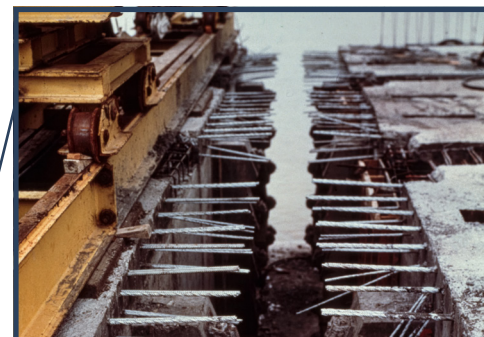
Le tablier du pont Mario M. Cuomo est composé de près de 6000 panneaux préfabriqués de 3,66 m de long et de 6,7 à 13,7 m de large pour les travées d'approche, et de 963 panneaux pour la travée principale. Les panneaux sont assemblés en coulant du béton autour des armatures en acier galvanisé qui dépassent. (Image reproduite avec l'aimable autorisation de la New York State Thruway Authority)
