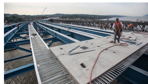
Le tablier du pont Mario M. Cuomo est composé de près de 6000 panneaux préfabriqués de 3,66 m de long et de 6,7 à 13,7 m de large pour les travées d'approche, et de 963 panneaux pour la travée principale. Les panneaux sont assemblés en coulant du béton autour des armatures en acier galvanisé qui dépassent. (Image reproduite avec l'aimable autorisation de la New York State Thruway Authority)
