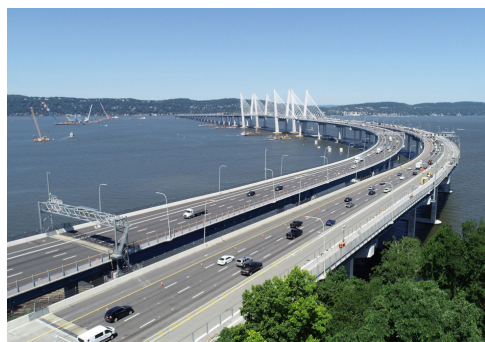
Le pont Mario M. Cuomo est un pont à haubans de 5 km de long, à 8 voies et à deux travées, conçu pour une durée de vie minimale de 100 ans et utilisant des armatures galvanisées.
