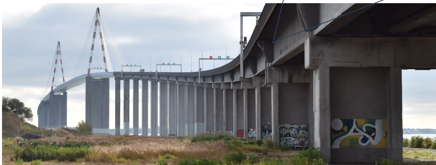
Le Pont de Saint-Nazaire, construit dans les années 1970, est toujours le plus long pont de France. La plupart de ses armatures n'ont pas été protégées contre la corrosion, ce qui a conduit à un vaste programme d'entretien et de réparations. Environ 63 tonnes d'armatures galvanisées ont été utilisées dans des endroits très spécifiques : les brides des extrémités des poutres en T et les dalles de liaison coulées in situ positionnées à hauteur des brides (photo ci-dessus). Les emplacements où les armatures galvanisées ont été utilisées n'ont pas nécessité de rénovation.
