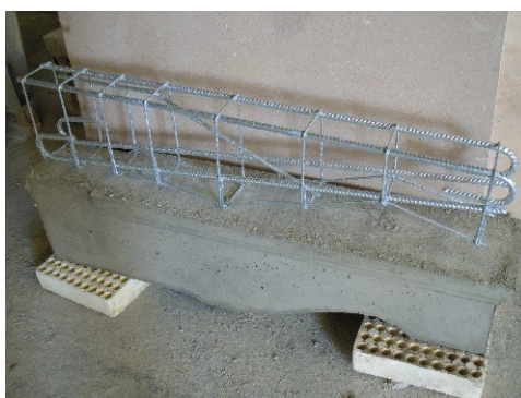
Poutres de soutien en béton armé avec armatures en acier galvanisé à chaud pour les balcons d'un élégant appartement à Gênes. Les armatures en acier galvanisé ont été choisies pour préserver au mieux les poutres de soutien des balcons dans le temps, en particulier pour les protéger du brouillard, de la pluie, du gel et de l'humidité. (Images reproduites avec la permission de Prefabbricati Torti di Pietro e Lino Torti snc)
