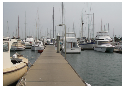
Les pontons flottants de la marina de Sandringham, dans l'État de Victoria (Australie), ont été renforcés par des armatures galvanisées.
