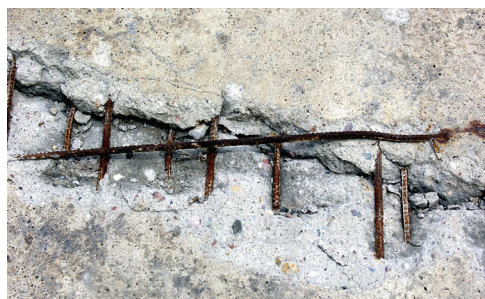
Fissuration et écaillage du béton en raison de la corrosion de l'acier pour béton armé.
