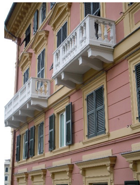
Poutres de soutien en béton armé avec armatures en acier galvanisé à chaud pour les balcons d'un élégant appartement à Gênes. Les armatures en acier galvanisé ont été choisies pour préserver au mieux les poutres de soutien des balcons dans le temps, en particulier pour les protéger du brouillard, de la pluie, du gel et de l'humidité. (Images reproduites avec la permission de Prefabbricati Torti di Pietro e Lino Torti snc)
