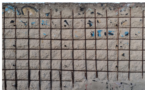
Fissuration et écaillage du béton en raison de la corrosion de l'acier pour béton armé.
