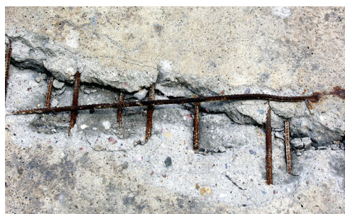
Fessurazione e sfaldamento del calcestruzzo dovuti alla corrosione dell'acciaio dell'armatura
