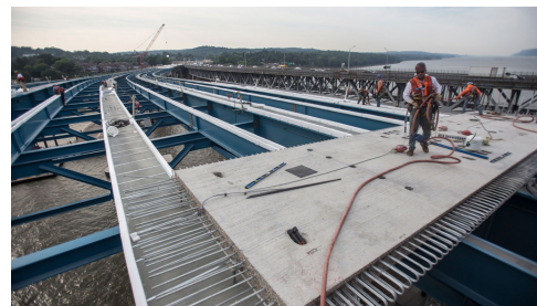
L'impalcato del ponte Mario M. Cuomo comprende circa 6000 pannelli prefabbricati lunghi 3,66m e larghi 6,7-13,7m per le campate di avvicinamento e 963 pannelli per le campate principali. Il raccordo dei pannelli è stato effettuato mediante dei getti di calcestruzzo eseguiti attorno all'armatura sporgente in acciaio zincato. (Immagine gentilmente concessa dalla New York State Thruway Authority)
