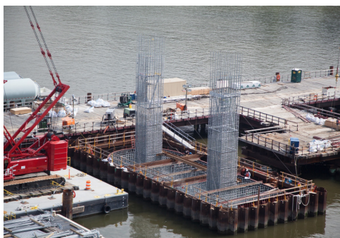
Oltre 27.000 tonnellate di armature in acciaio zincato garantiscono una durata di vita prolungata alle torri delle campate principali, ai pilastri della campata di accesso, alle spalle e ai pannelli dell'impalcato stradale del Ponte Mario M. Cuomo.
