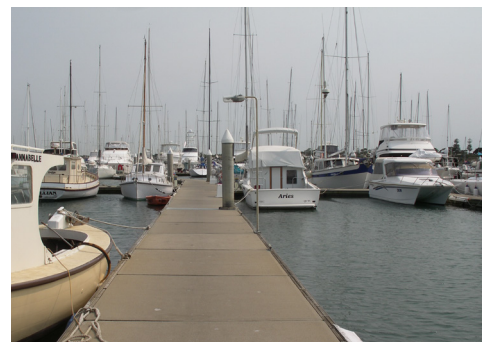
I pontili galleggianti del porto turistico di Sandringham, Victoria (Australia) sono stati realizzati con armature zincate.
