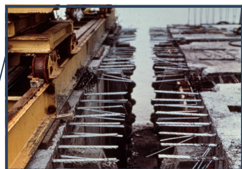
L'impalcato del ponte Mario M. Cuomo comprende circa 6000 pannelli prefabbricati lunghi 3,66m e larghi 6,7-13,7m per le campate di avvicinamento e 963 pannelli per le campate principali. Il raccordo dei pannelli è stato effettuato mediante dei getti di calcestruzzo eseguiti attorno all'armatura sporgente in acciaio zincato. (Immagine gentilmente concessa dalla New York State Thruway Authority)
