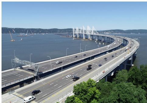
Il ponte Mario M. Cuomo è un ponte sospeso, a doppia campata, lungo 5 km, a 8 corsie. Il ponte è progettato per raggiungere una durata di vita minima di 100 anni mediante l'utilizzo di armature zincate a caldo.
