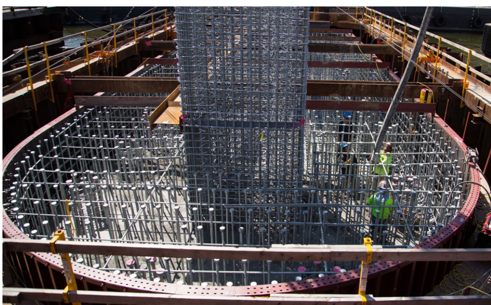
Le armature delle 43 coppie di pilastri in cemento armato del ponte Mario M. Cuomo sono realizzate con gabbie in acciaio zincato.
