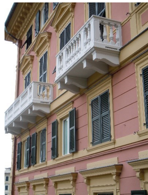
Mensole in cemento armato realizzate con acciaio zincato a caldo per i balconi di un elegante appartamento a Genova. L'armatura in acciaio zincato è stata scelta per preservare al meglio le mensole nel tempo, in particolare per proteggerle da smog, piogge, gelo e umidità. (Immagini gentilmente concesse dall'azienda Prefabbricati Torti di Pietro e Lino Torti snc)
