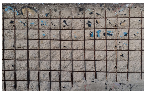
Fessurazione e sfaldamento del calcestruzzo dovuti alla corrosione dell'acciaio dell'armatura
