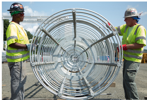
Il ponte Mario M. Cuomo è un ponte sospeso, a doppia campata, lungo 5 km, a 8 corsie. Il ponte è progettato per raggiungere una durata di vita minima di 100 anni mediante l'utilizzo di armature zincate a caldo.
