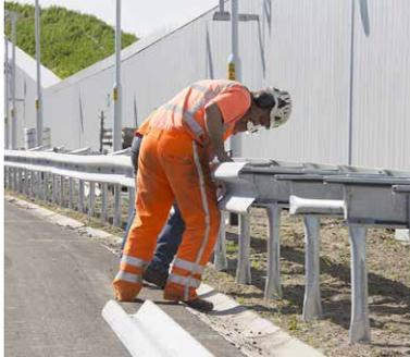
Las barreras de acero galvanizado para carreteras se pueden desmontar para reutilizar o regalvanizar logrando hasta un 70% de reducción en emisiones de CO<sub>2</sub>
