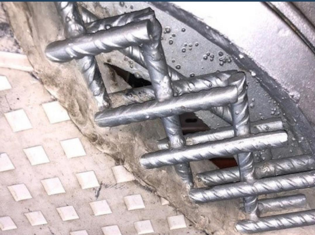
Las Armaduras Galvanizadas en productos y estructuras de hormigón pueden proporcionar grandes beneficios. En ambientes agresivos, puede evitar la necesidad de incrementar el recubrimiento de hormigón. Cuando se requieran diseños de hormigón más livianos y delgados, la armadura galvanizada protegerá contra la carbonatación.
