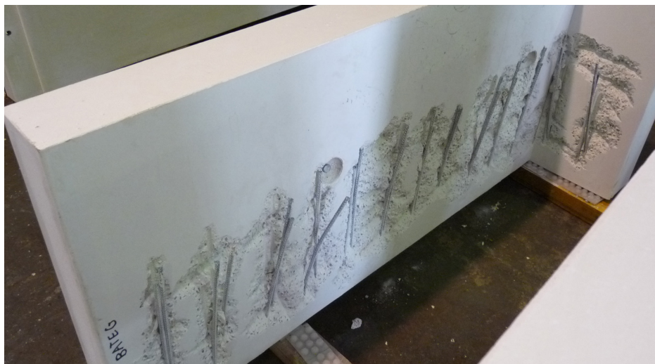
Armature zincate esposte durante la costruzione
